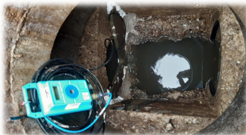
Installation seuil pour point de mesure OR
