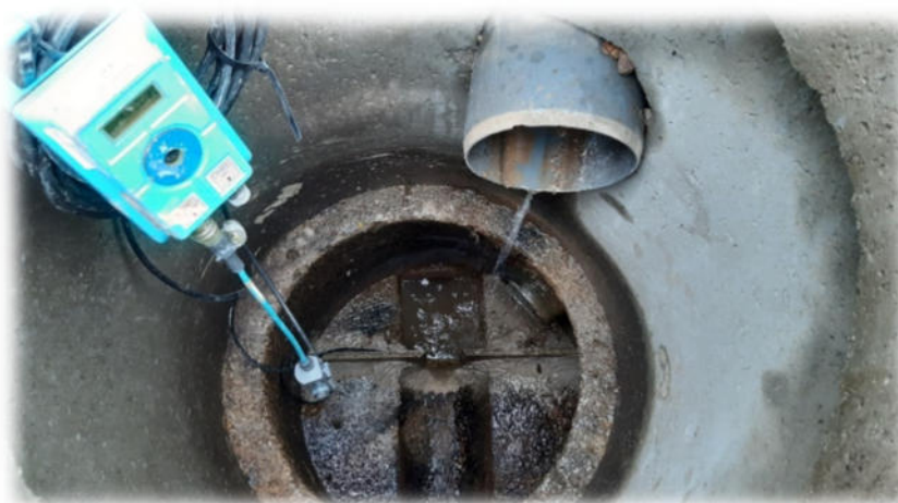
Installation seuil pour point de mesure B
