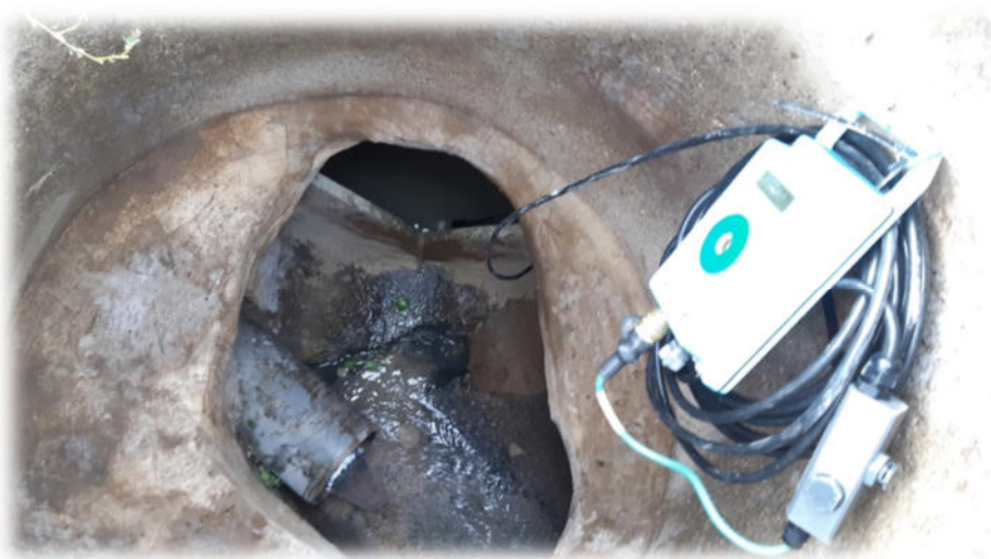
Installation seuil pour point de mesure A
