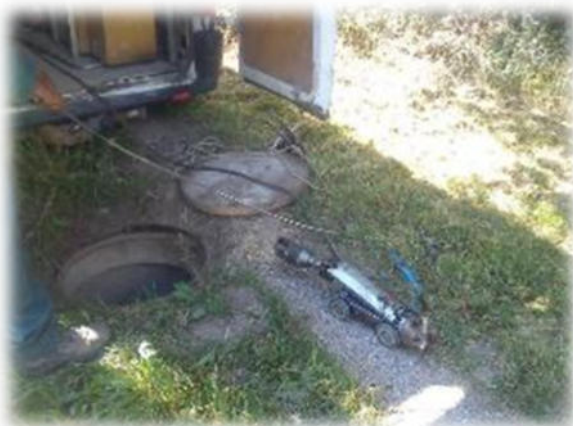
Photos de la caméra inspectrice sur charriot motorisé
