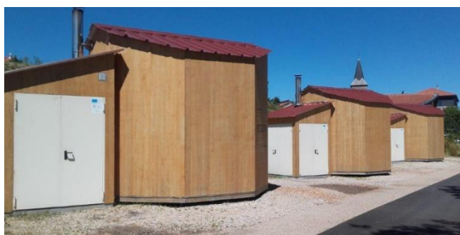
Réseau de chaleur Saint-Bonnet-le-Froid
